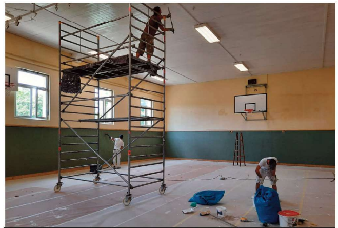
Malerarbeiten (Fa. Rath) an der Decke und an der Wand
